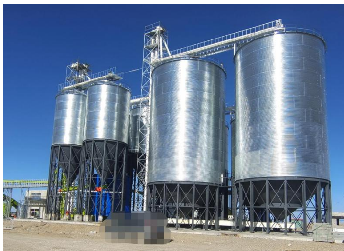
精料存储及添加技术应用现场
