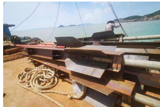
(d) 火箭桩锚施工
