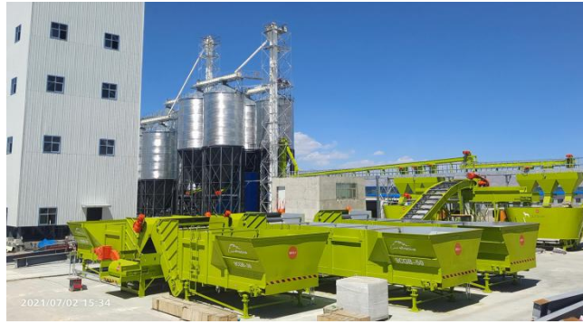
粗饲料输送技术应用现场
